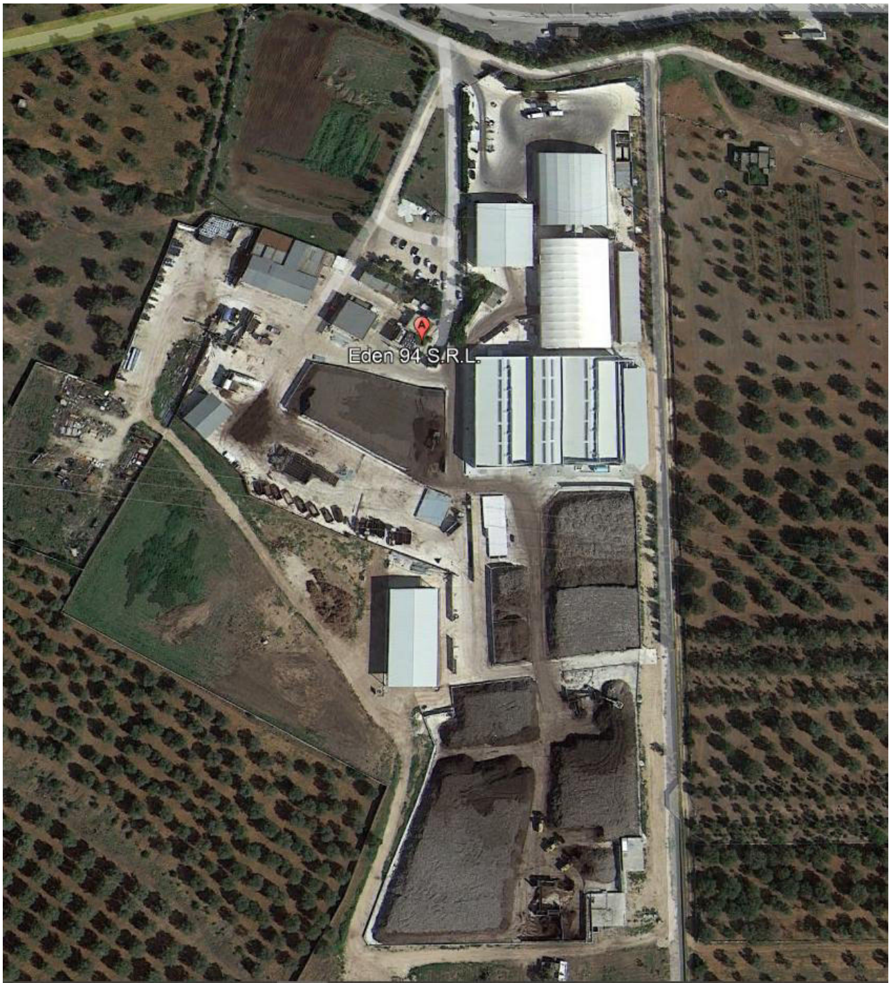
Fig.2 - Vista aerea dell'impianto
