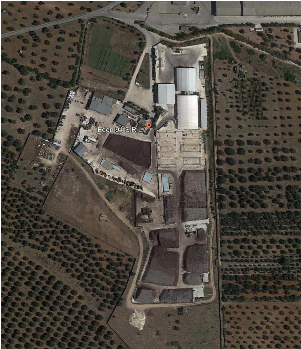
Fig.2 - Vista aerea dell'impianto
